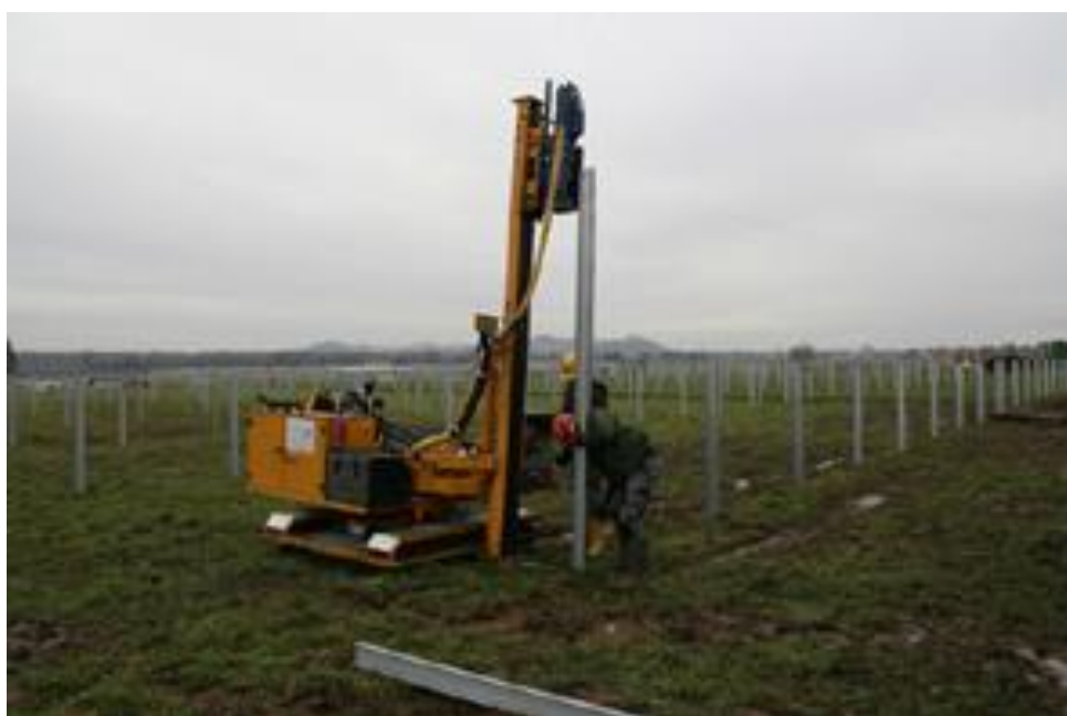
Zdjęcie 2 Montaż profili za pomocą kafara.
